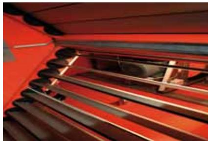
links: Im Dachgeschoss des ITZ wird die Wärme für die Büro- und Seminarräume nach den Himmelsrichtungen verteilt und geregelt.
