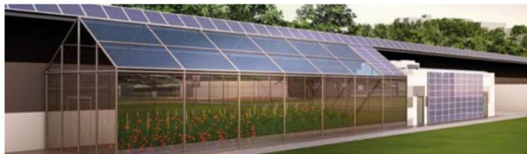
Das Modell, das auf dem Campus der Hochschule entsteht, besteht aus zwei Teilen: einem Serverbereich, der in erweiterbarer Containerbauweise vorproduziert und anschließend am Standort aufgestellt werden und dem damit verbundenen Gewächshaus, welches die Abwärme der Server ganzjährig für die Aufzucht von Pflanzen nutzt. Auf dem Dach des Rechenzentrums erzeugen Photovoltaikanlagen Strom für den Betrieb der Server.
