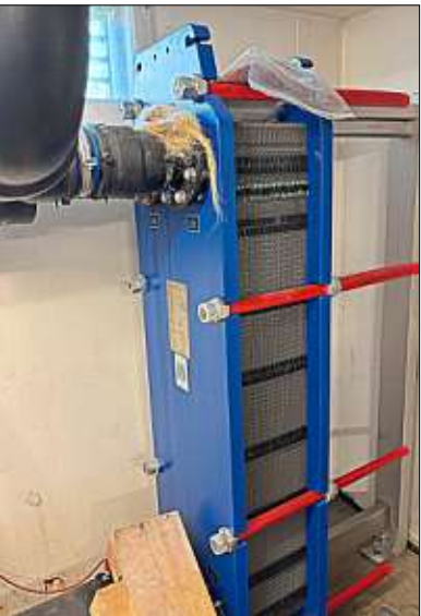
Herzstück: Der Wärmetauscher wandelt Flusswasser in Energie um.
